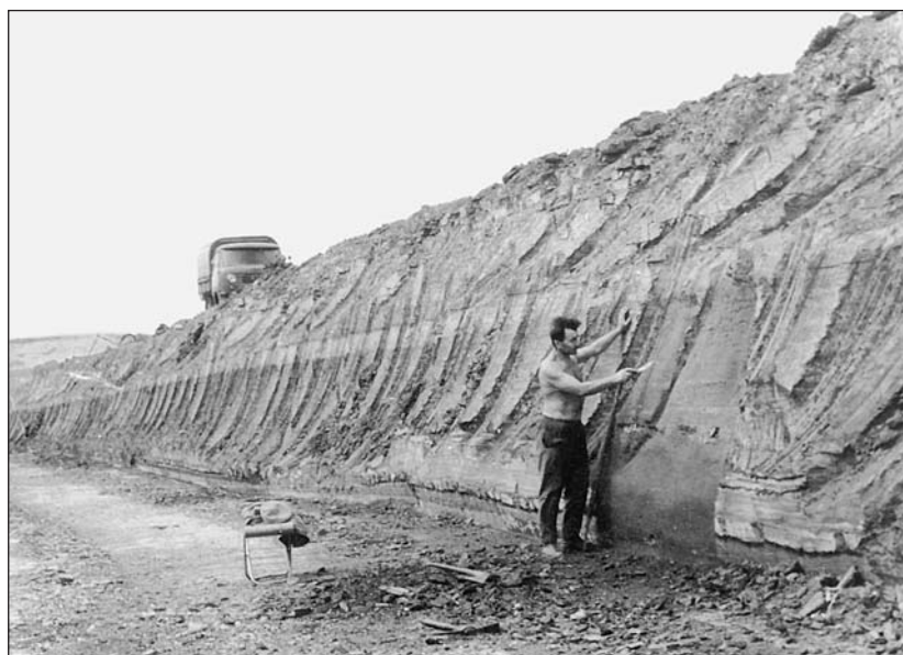
Разрез рудной залежи в забое карьера.
